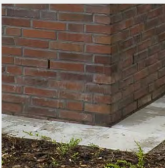
Hohe Beanspruchung durch Frost und Durchfeuchtung nahe der Oberfläche.
