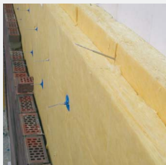
Multiluftschichtanker zur Verankerung von zweischaligen Außenwänden (Schalenabstand \leq 20 cm).
