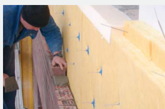
Ausführungsbeispiel für zweischaliges Mauerwerk mit Kerndämmung.
