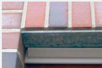
Das senkrecht angeordnete Widerlager kann keine tragende Funktion übernehmen.
