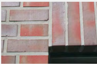
Das senkrecht angeordnete Widerlager kann keine tragende Funktion übernehmen.
