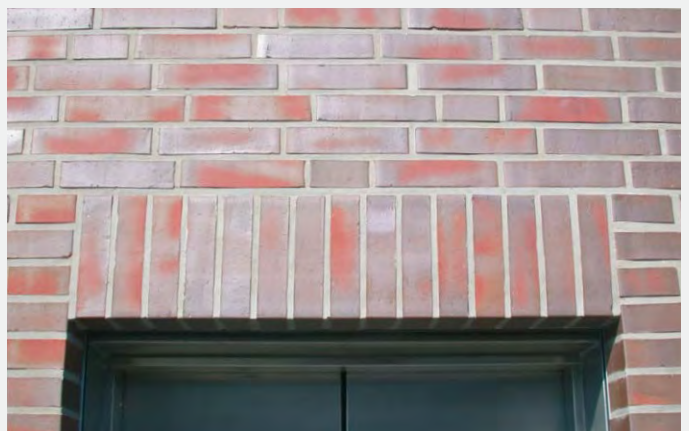
Sturz im Ziegelverblendmauerwerk aus „gemauerte Rollschicht“ (Grenadierschicht)
