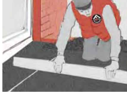
18. Ist die Fläche abgezogen ist darauf zu achten, dass die Randeinfassung ca. einen Zentimeter tiefer liegt als die fertig verdichtete Pflasterung. Werden schmale Flächen wie z. B. Wege abgezogen, kann die seitliche Einfassung als Lehre genutzt werden. Hierfür wird die Abziehlatte entsprechend der Steindicke und des kalkulierten Verdichtungsmaßes an den Enden ausgespart.
