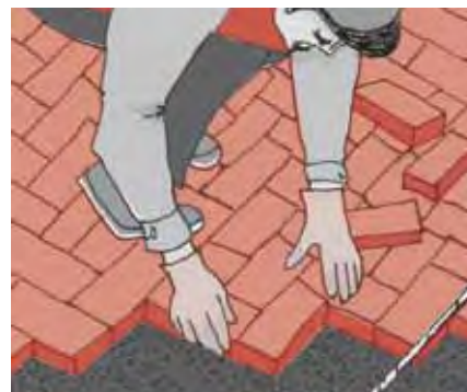
24. Die Pflasterarbeiten werden immer vorwärts von der verlegten Fläche ausgeführt.
