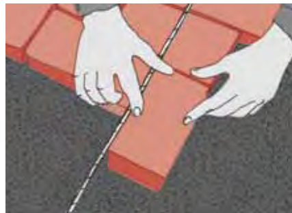
21. Mit der Richtschnur kann die Ausrichtung des Verbandes kontrolliert werden. Für eine Flachverlegung wird eine Mindestfuge von 3 bis 4 mm gefordert. Entscheidende Gründe dafür sind zum einen der notwendige Ausgleich der unvermeidbaren Herstellungstoleranzen und zum anderen die Stabilität der Fläche, die nur durch vollflächige ausgefüllte Fugen erbracht werden kann. Durch Belastungen des Belages treten Schubkräfte auf, die durch die Fuge ausgeglichen werden. Die Fuge vermeidet dabei, dass das Pflastermaterial aneinander kantet und Abplatzungen entstehen.
