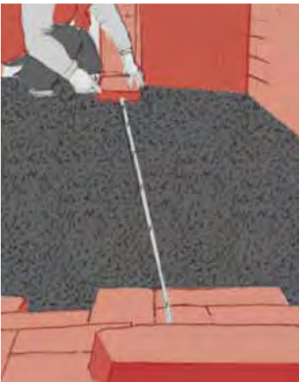
20. Eine Richtschnur wird je nach Verlegeverband abschnittsweise gezogen, um die Fugenflucht, Fugendicke und den Verband der verlegten Pflasterfläche zu bewahren.
