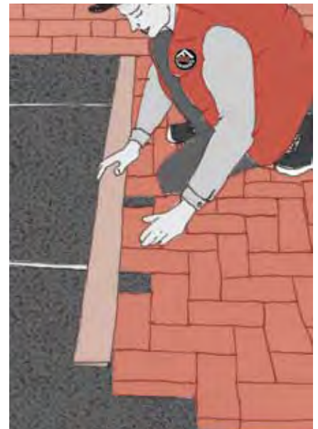
22. Eine kontinuierliche Überprüfung aller Fluchten, auch der Querflucht, ist im Verlauf der Pflasterung vorzunehmen.
